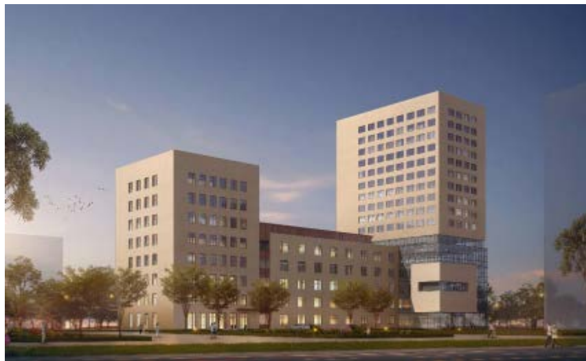
在建研发中心大楼
