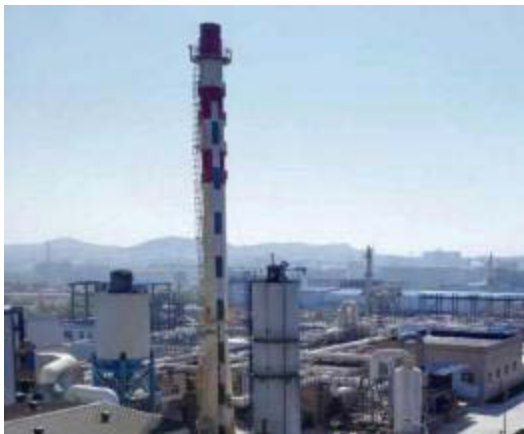
生产基地污水处理系统外景
